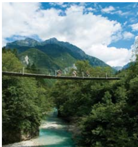
Hängebrücke im Soča-Tal (1. Etappe)
