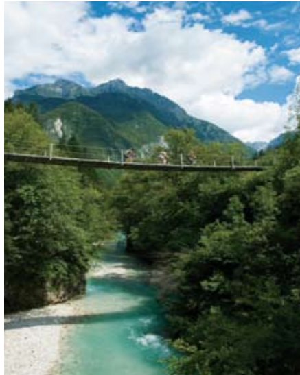
Hängebrücke im Soča-Tal (1. Etappe)
