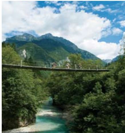
Hängebrücke im Soča-Tal (1. Etappe)
