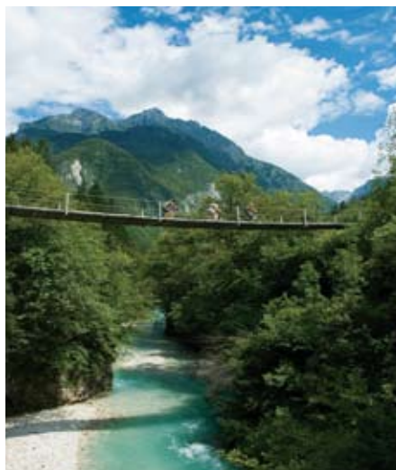
Hängebrücke im Soča-Tal (1. Etappe)
